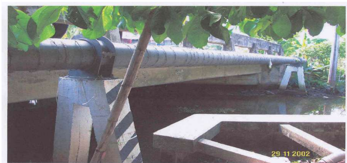
ภาพที่ 3 การวางท่อไปกับสะพาน
