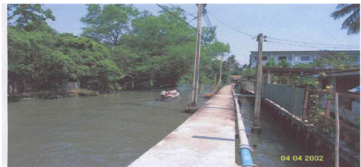
ภาพที่ 3 การวางท่อไปกับสะพาน
