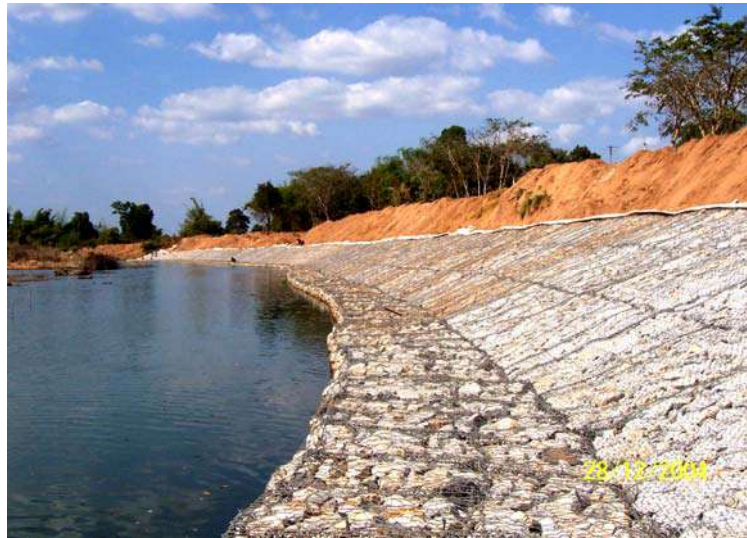
ภาพที่ 68 ตัวอย่างของเขื่อนประเทหินเรียงในคลองลวดตาข่าย
